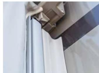
Мачтовые профили оснащены резиновыми уплотнениями, обеспечивающими защиту от царапин и водонепроницаемое уплотнение. Высоту можно легко отрегулировать.
